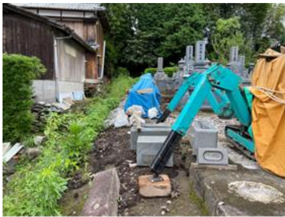
水路整備、墓地移設の様子
